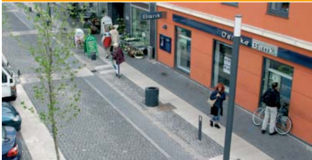
Et fint eksempel på en renoveret facade. Taastrup Hovedgade 87.
